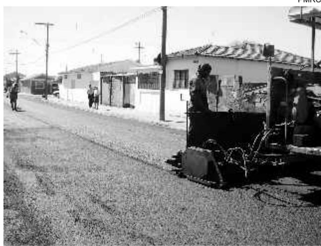
Jardim Olinda recebe pavimentação
